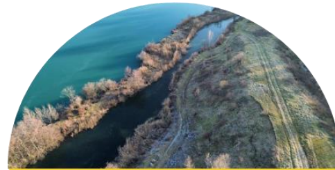
Plan d'eau de l'Eperon de Bilet Approfondissement 2025
