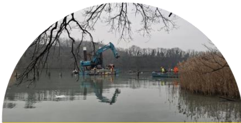
Lagune de Peney Approfondissement et nouveau seuil 2025
