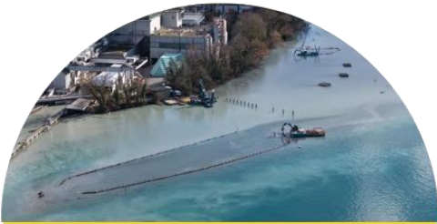
Lagune de Verbois Approfondissement et nouveau seuil 2025
